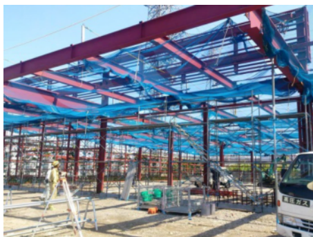
某倉庫新築工事(鉄骨造平屋建)
