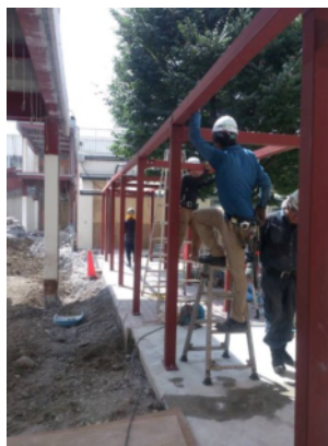
某小学校耐震補強工事
