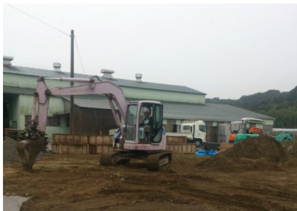
某倉庫基礎工事
