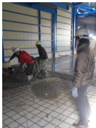
某倉庫土間工事
