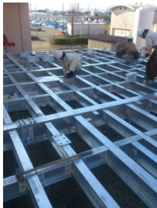
某病院設備架台工事
