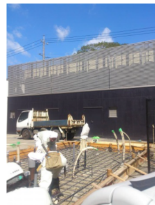
某病院設備架台基礎工事
